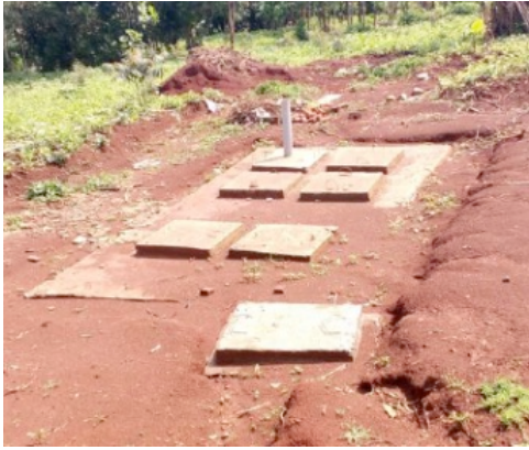
Fosa séptica en ejecución a falta de cierre perimetral
