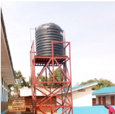
Instalación de depósito de 3.000 l elevado para distribución a los puntos de consumo y fuente.
