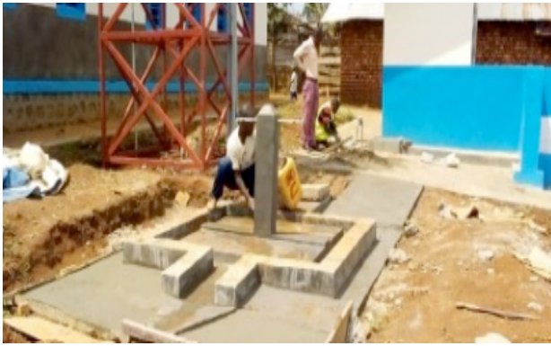
Instalación de fuente para agua potable
