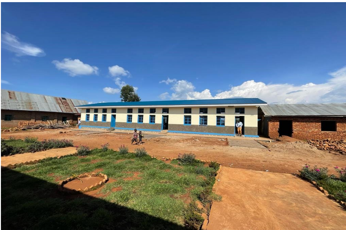
Vistas del nuevo módulo terminado e interior de una clase. Mayo 2023
