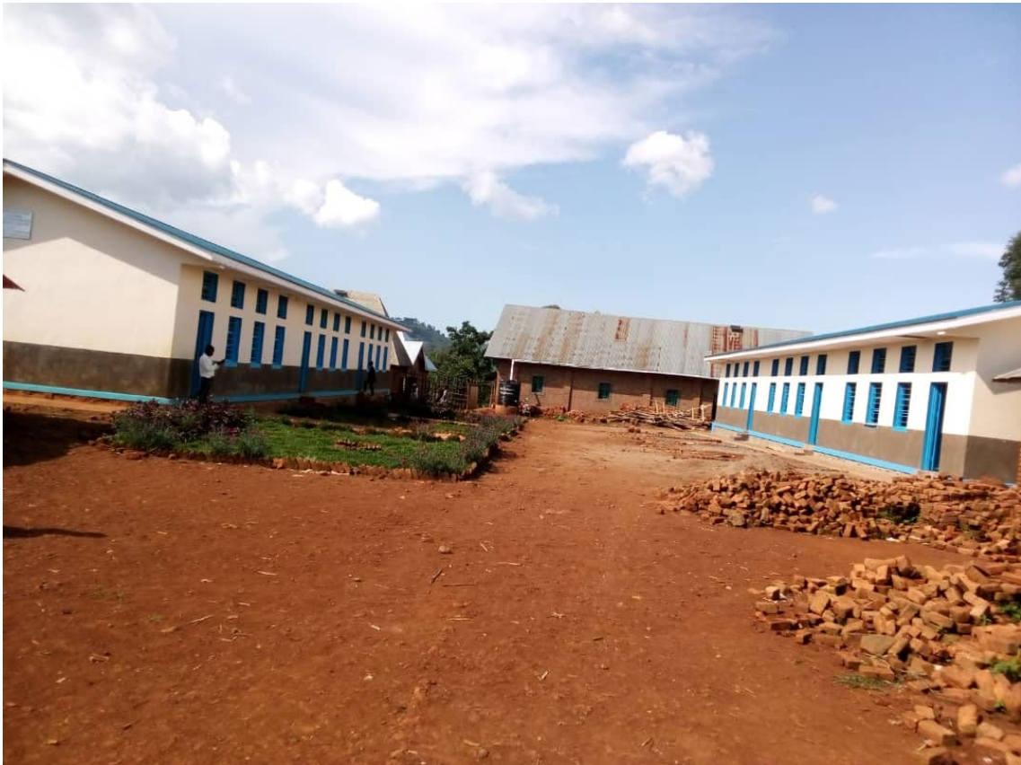
Vista de los dos módulos construidos en fase 1 y fase 2.1 para la escuela primaria Nyabunyunyi
